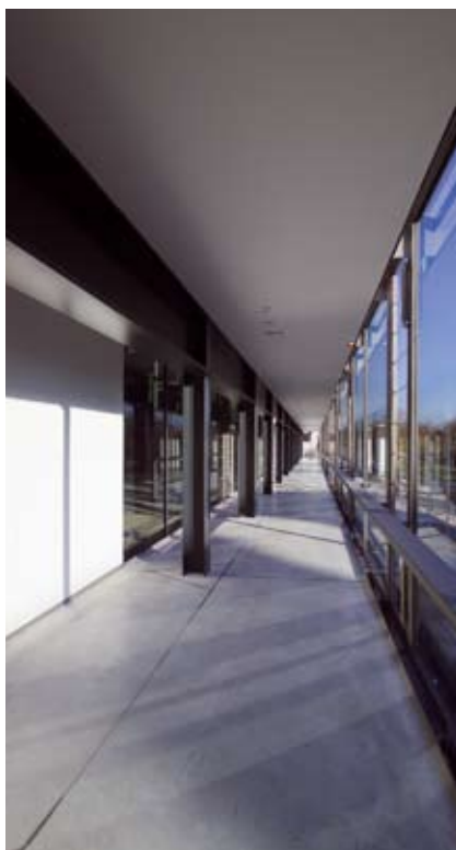
A l'avant du bâtiment se trouve l'axe public qui mène aux greffes et aux salles d'audience sur les différents niveaux.
