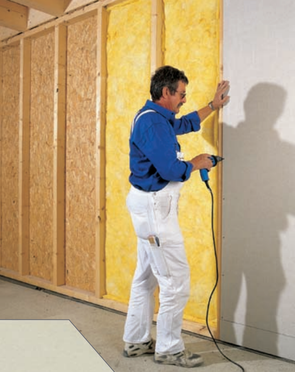
La combinaison unique de plâtre et de cellulose confère aux plaques Vidiwall et Vidifloor une dureté de surface et une résistance à la déformation exceptionnelles.
